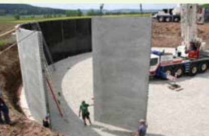
▲ Fertigteilmontage
