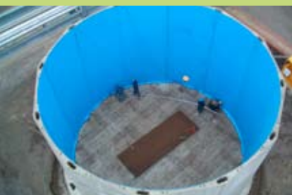
▲ Fertigteilbauweise mit Schutzauskleidung
