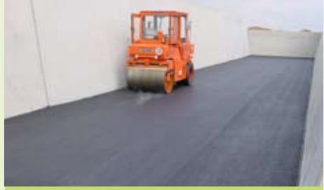
▲ Fahrsilo mit Asphaltboden
