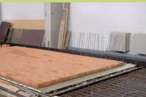
▲ Vorfertigung im Werk
