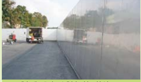
▲ Fahrsilowände mit Edelstahlauskleidung oder mit HDPE-Beton Schutzpaletten
