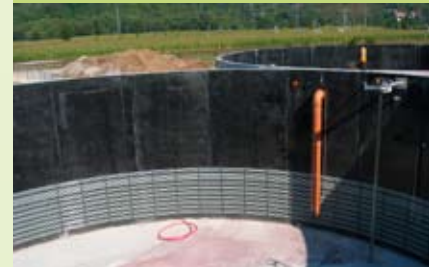
▲ HDPE-Schutzauskleidung & Fermenterheizung
