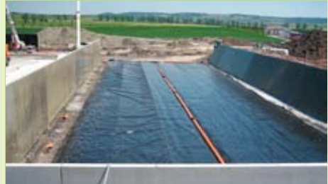
▲ Dichtfolie und Entwässerungsleitung
