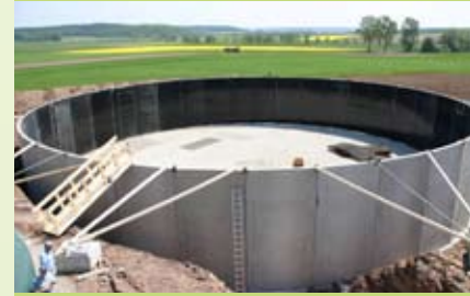
▲ Behälter aus Fertigteilen 36 m Ø
