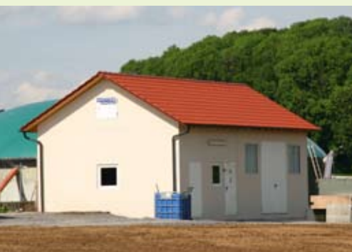
▲ BHKW-Raum mit Trafostation
