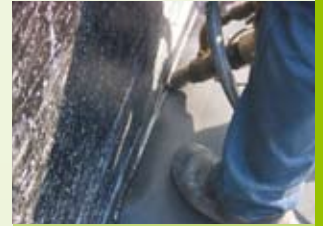
▲ Extruderschweißnaht
