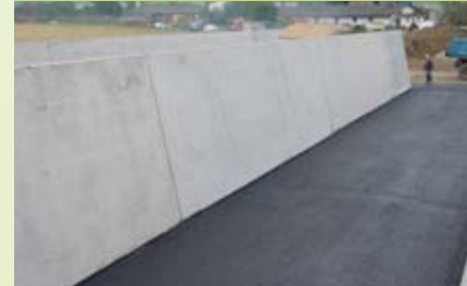
▲ Fahrsilo mit Asphaltboden
