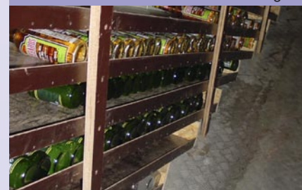
▲ Das innenliegende Batterielager
