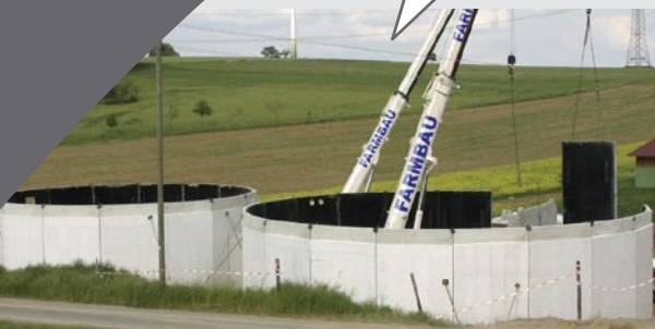
▲ Fermenter und Nachgärlager für Biogasanlagen in Fertigteilbauweise mit HDPE-Schutzfolie
